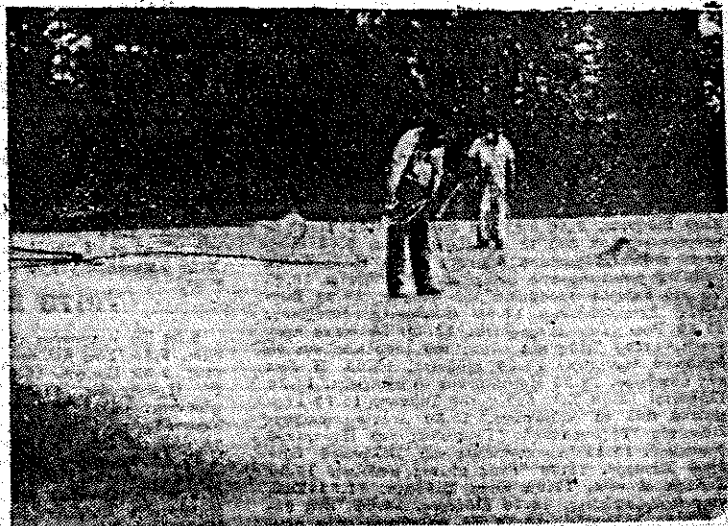
Μόνωση ταρτσῶν με «πολυουρεθάνη» διὰ ψεκασμοῦ.
