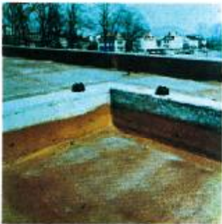
Η σφράγιση των ραγμών, άρμών, φωνιών κλπ. κτηρίων και προσαρμοσμένων αντικειμένων επί της τάρτσας, δέν παρουσιάζουν κομιά δυσκολία, διά της μονώσεως με πολυουρεθάνη.
