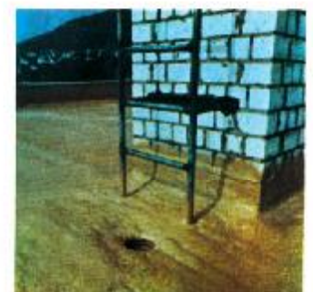
Η σφράγιση των ραγμών, άρμών, φωνιών κλπ. κτηρίων και προσαρμοσμένων αντικειμένων επί της τάρτσας, δέν παρουσιάζουν κομιά δυσκολία, διά της μονώσεως με πολυουρεθάνη.
