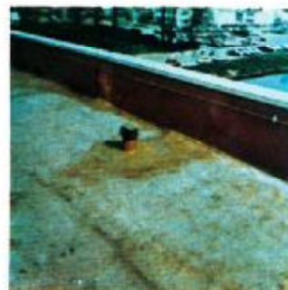
Η σφράγιση των ραγμών, άρμών, φωνιών κλπ. κτηρίων και προσαρμοσμένων αντικειμένων επί της τάρτσας, δέν παρουσιάζουν κομιά δυσκολία, διά της μονώσεως με πολυουρεθάνη.
