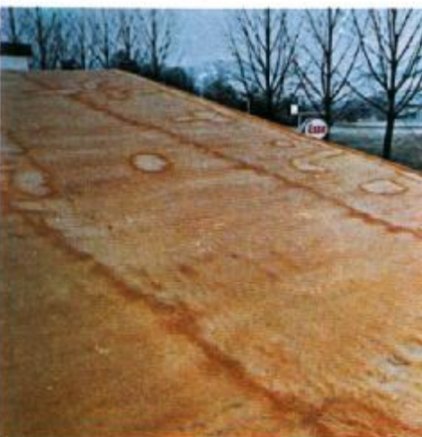
Ευκόλη, ταχεία και ιδιανική μόνωση διαφόρων σιλό και δεξαμεμών καισιμιν διά Spray Πολυουρεθάνης. Μπορεί να επακολουθήσει οποιαδήποτε βαφή ή βερνί με πολυουρεθανικό αλουμνιο.
