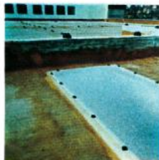
Η σφράγιση των ραγμών, άρμών, φωνιών κλπ. κτηρίων και προσαρμοσμένων αντικειμένων επί της τάρτσας, δέν παρουσιάζουν κομιά δυσκολία, διά της μονώσεως με πολυουρεθάνη.
