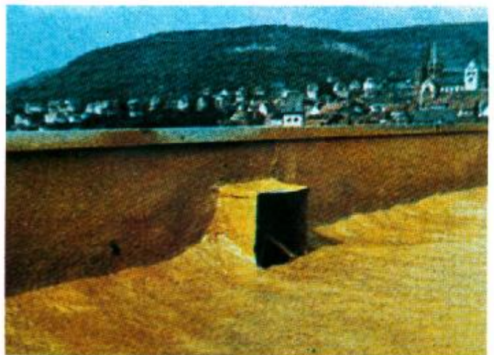
ΑΠΟΠΕΡΑΤΩΣΙΣ μονώσεως τάρτσας διά πολυουρεθάνης εις την όποιαν θά επακολουθήσει ενδεχομένως επίστρωση μαλτοζοπλάκας (λάσπη-πλάκα).
