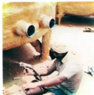
Ευκόλη, ταχεία και ιδιανική μόνωση διαφόρων σιλό και δεξαμεμών καισιμιν διά Spray Πολυουρεθάνης. Μπορεί να επακολουθήσει οποιαδήποτε βαφή ή βερνί με πολυουρεθανικό αλουμνιο.
